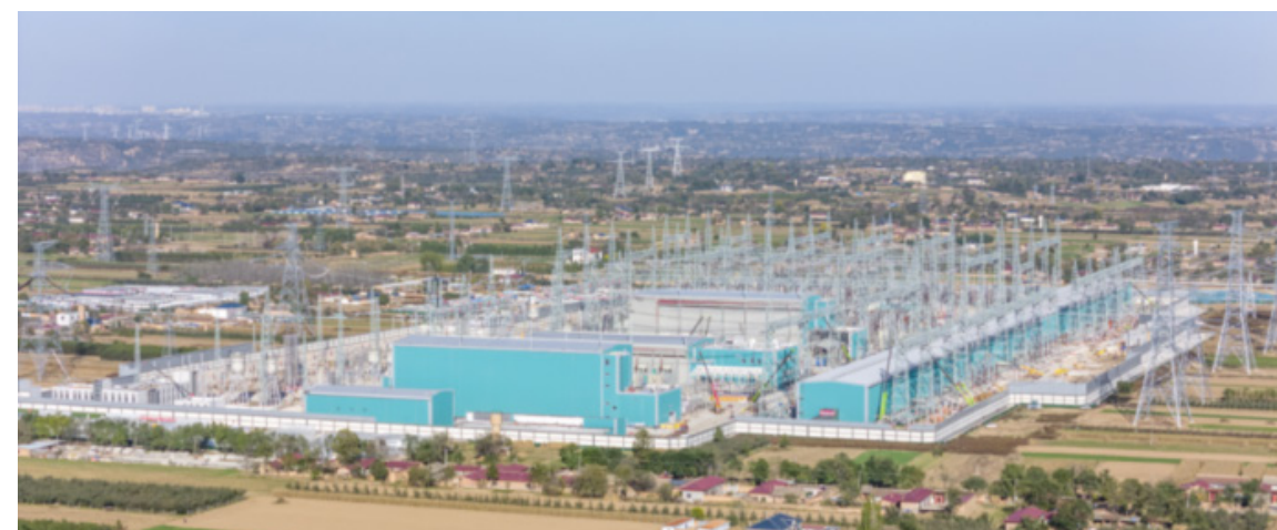
陇东 - 山东 \pm 800 千伏特高压直流工程
