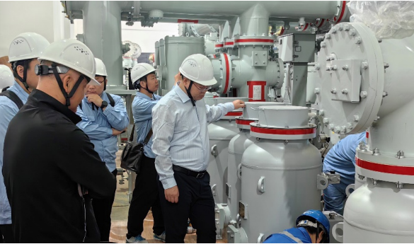
平芝公司现场安装质量检查
